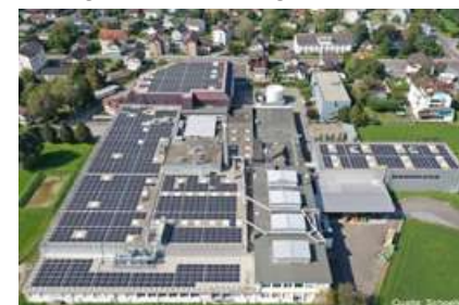
Schoeller Textile 生產基地安裝了太陽能模組
